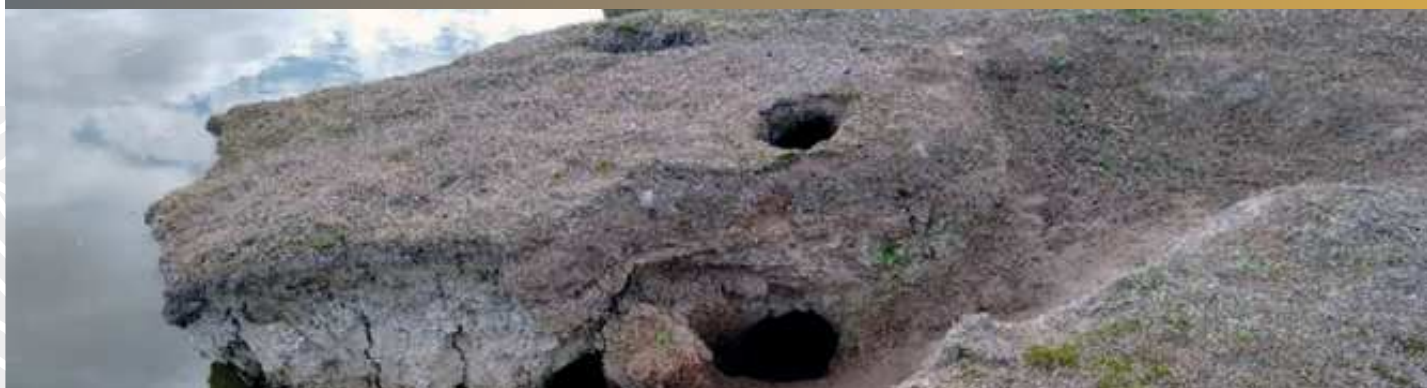
Dégradations de berge occasionnées par des ragondins
