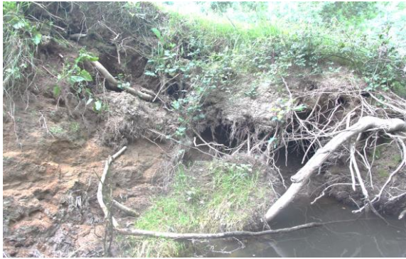
Photo 9 : effondrement de berge sur la Boulogne © Polleniz
